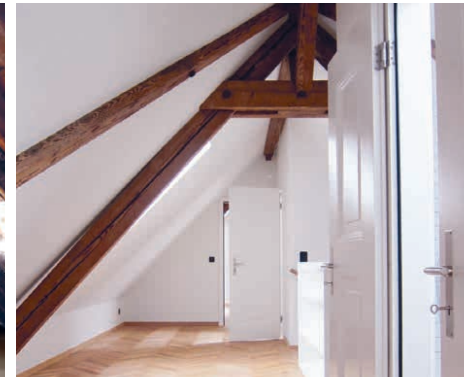
L'ingénierie: conseil et élaboration de solutions de détail, planification du système d'enduits et de construction à sec, établissement de la soumission, assurance de la conformité aux normes de protection acoustique et incendie, réception des travaux incluse.
