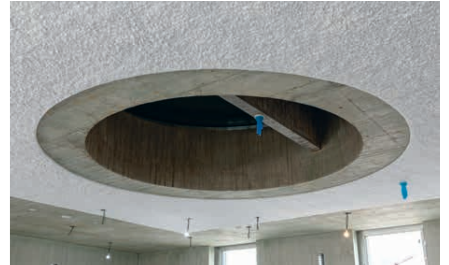
Akustikspritzputz (Sonasyr) mit scharf abgegrenzter, runder Form. Enduit acoustique à projeter (Sonasyr) avec des lignes arrondies, nettes et bien définies.
